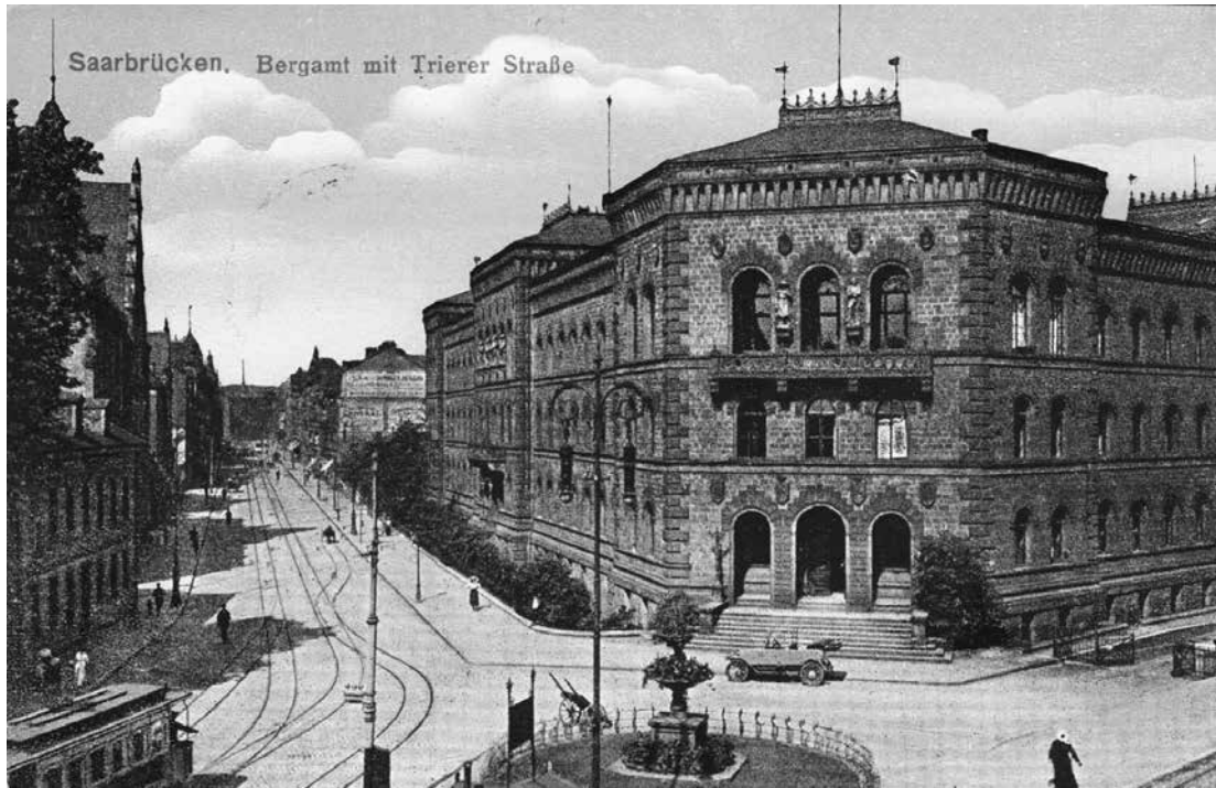
Saarbrücken, Bergamt mit Trierer Straße
