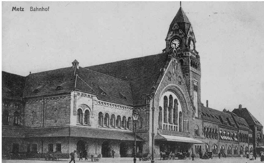
Der Bahnhof in Metz
